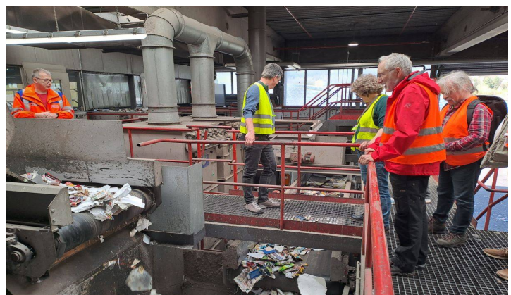
In der Sortieranlage
